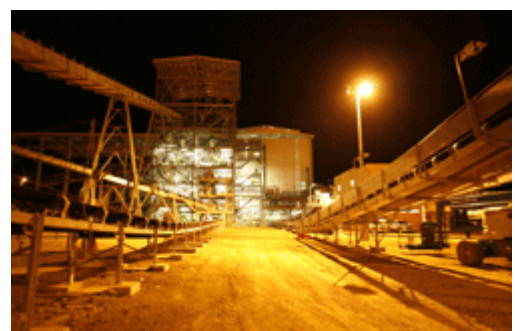
Figure 14 : Unité de traitement des minerais de nickel de Tiébaqhi (ERAMET)
