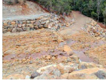
ancrage en berge et cuvettes déversoir
