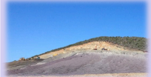
Dépôt de scories de l'usine KNS
