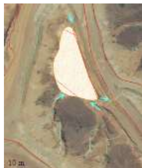
Figure 26 : Le bassin de décantation FRN01, 3 entrées, une sortie.
