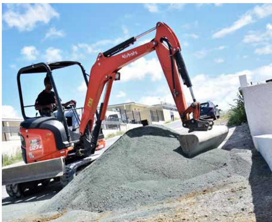
Pour l'instant, la scorie est surtout utilisée comme sous-couche lors de la réalisation de routes.
