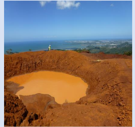
Bassin de décantation, massif du sud, commune du Montdore
