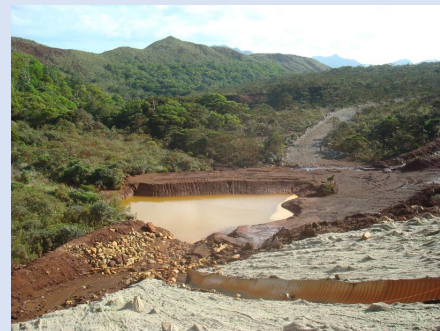
Ouvrage de gestion des eaux sur mine
