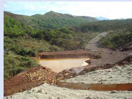
Ouvrage de gestion des eaux sur mine
