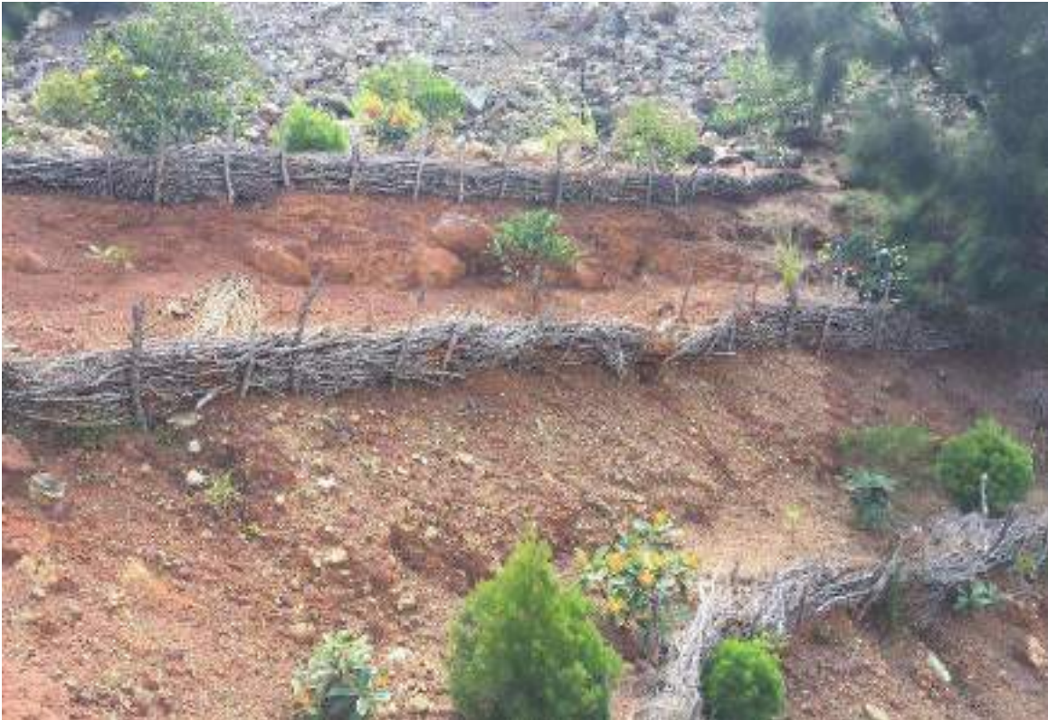
Fascine de branchages (photo : SIRAS)
