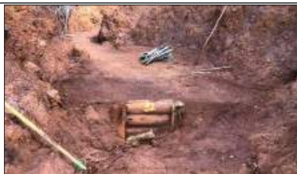
situation après effacement (les rondins restants en place sont plus visibles à l'annexe 7.2)
