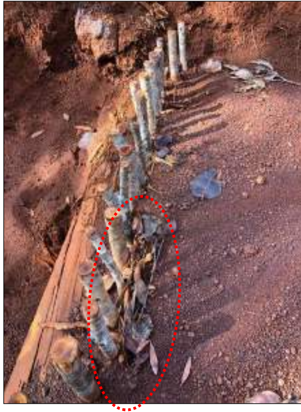
Figure 66 : L'effet « peigne » du cordon de boutures (seuil 2)
