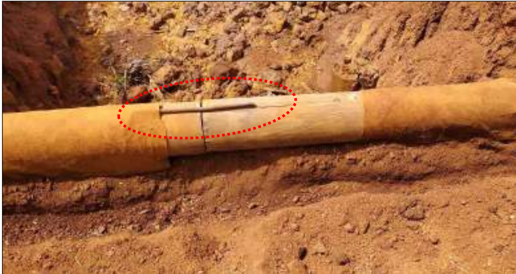
Figure 28 : Agrafe de mariage de 2 rondins dans le sens transversal
