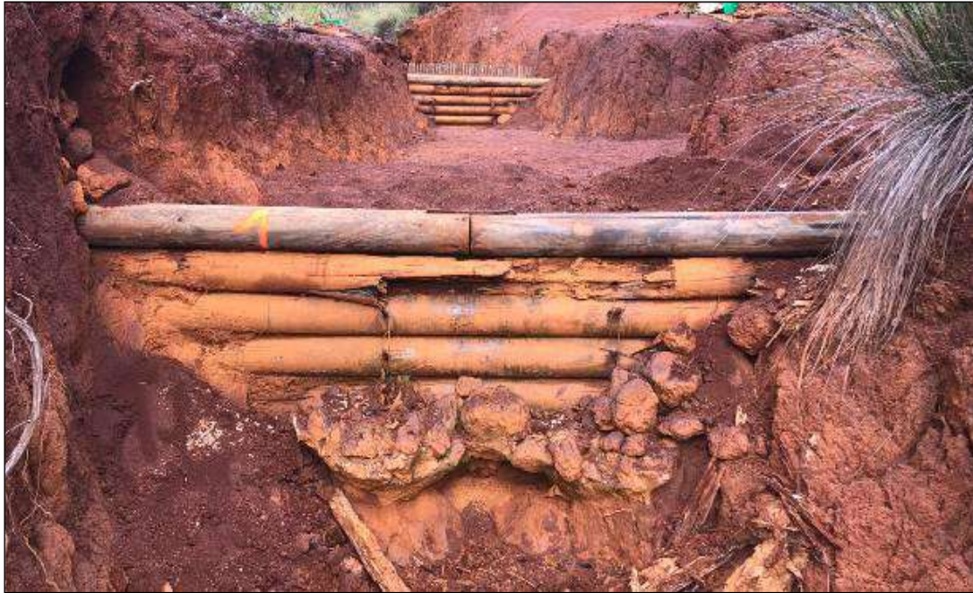
Seuil en bois (à simple paroi et sans déversoir) (photo : Y. Crosaz)
