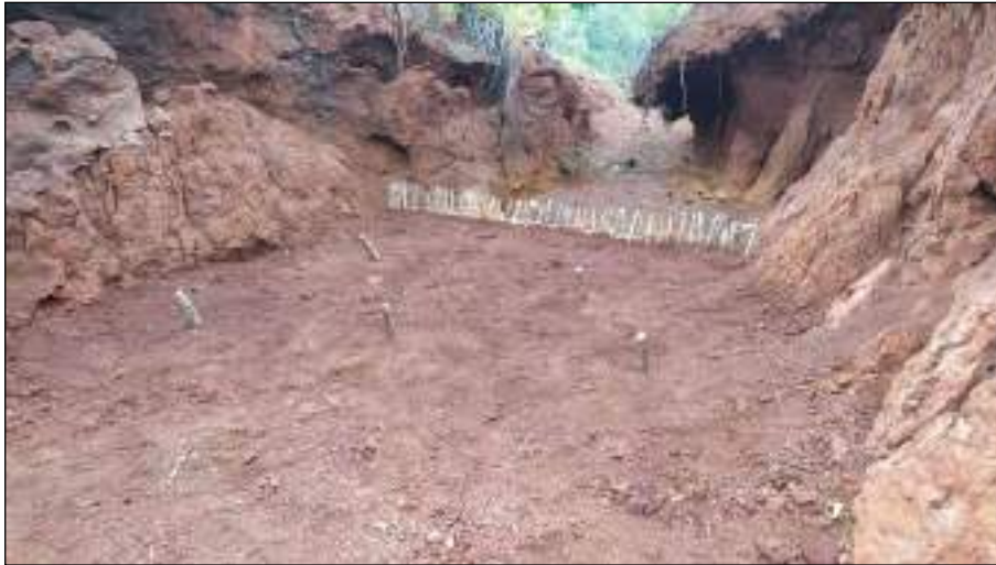
Figure 60 : Boutures de garnissage inclinées vers l'amont et atterrissement aplani (seuil 5)
