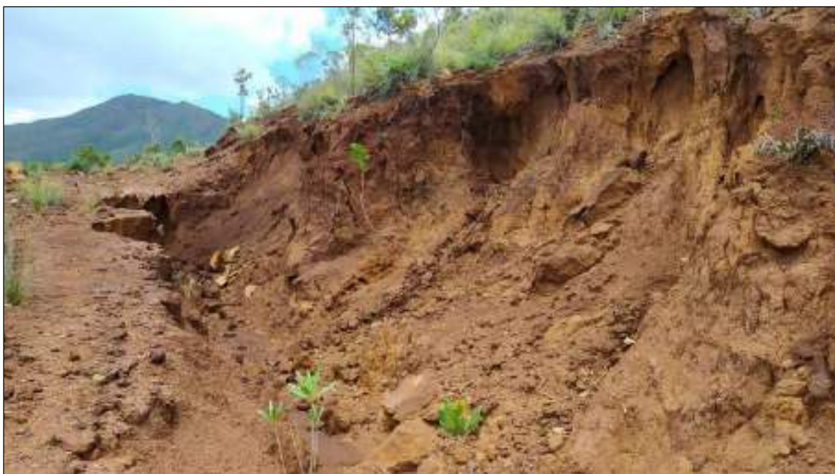
Photo déc. 2021 – vue amont de la piste
