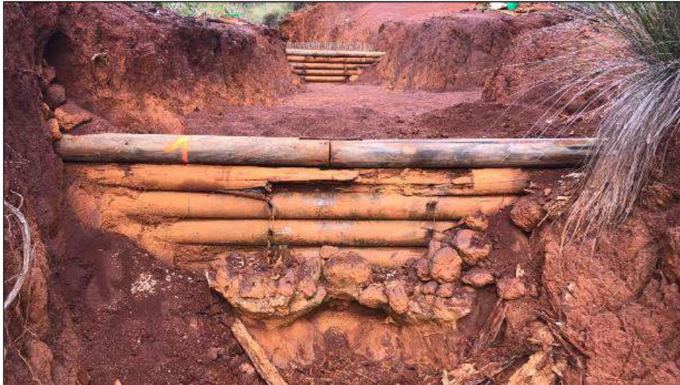
Figure 14 : Seuil en bois sans déversoir (Socamifer)
