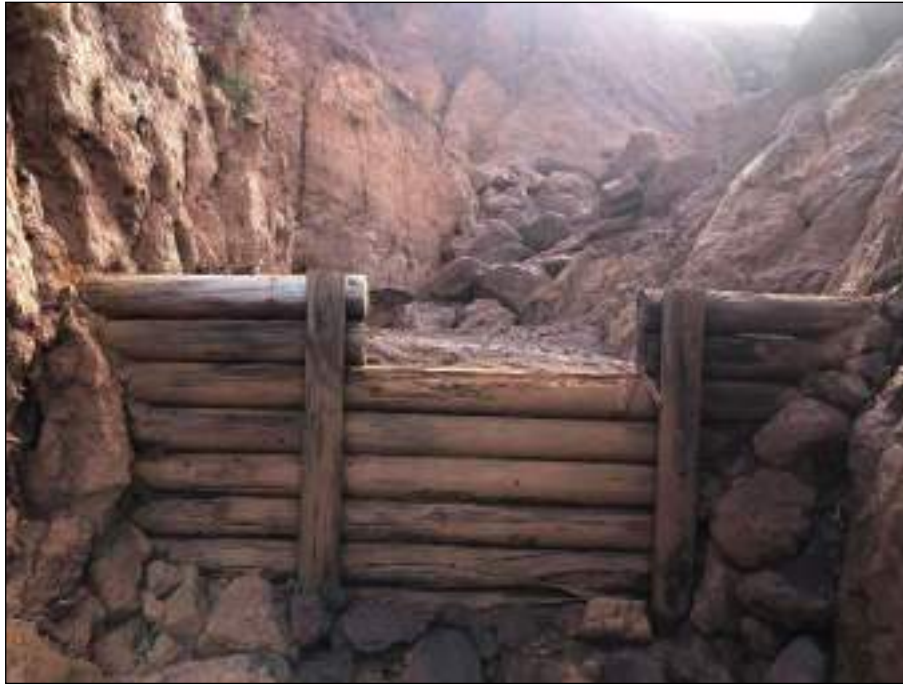
Figure 39 : Seuil n°13 dont le déversoir doit être effacé, Socamifer
