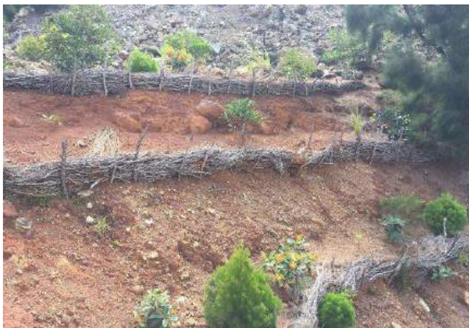
Figure 18 : Fascine de branchages (photo : SIRAS)
