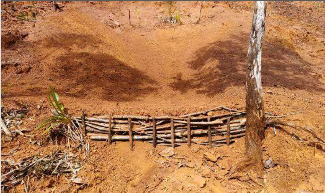
Fascine de boutures (photo : Y. Crosaz)
