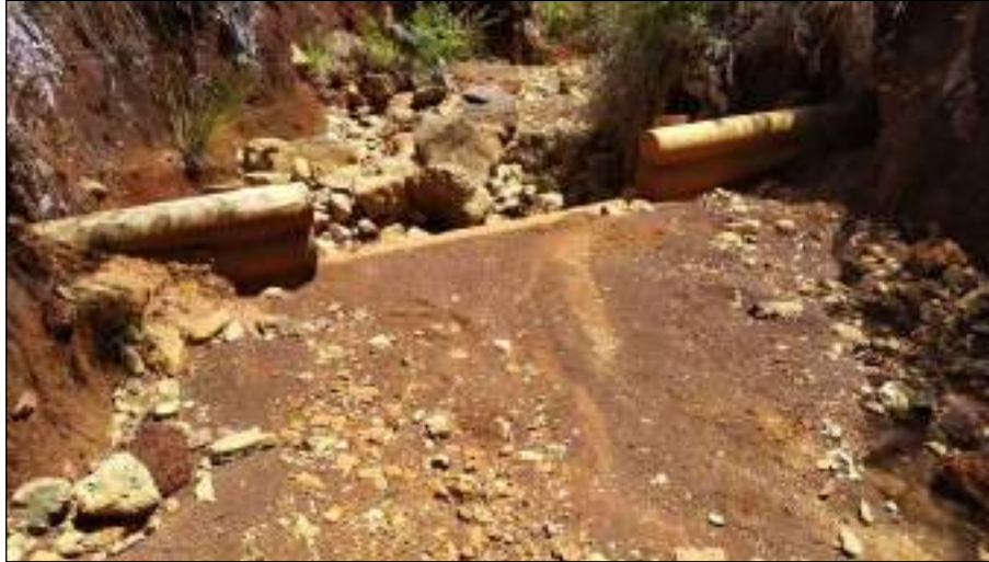
Figure 41 : Seuil n°3 dont il convient d'effacer le déversoir, Bel Air
