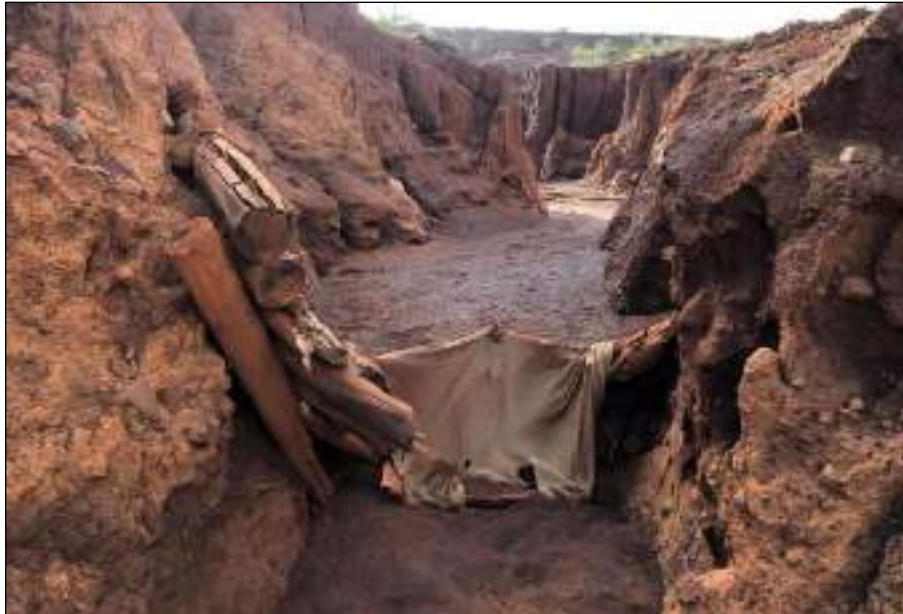
Figure 36 : Seuil n°2 à remplacer par un nouveau seuil à l'aval, Socamifer
