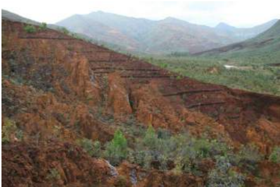
Figure 16 : Banquettes grillagées (photo : F. Rey)
