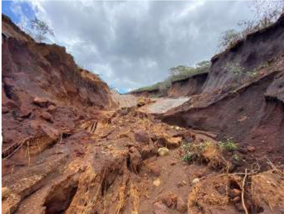
Figure 21 : Problème de tenue en place d'un géofilet dans le lit d'une ravine (photo : SIRAS)
