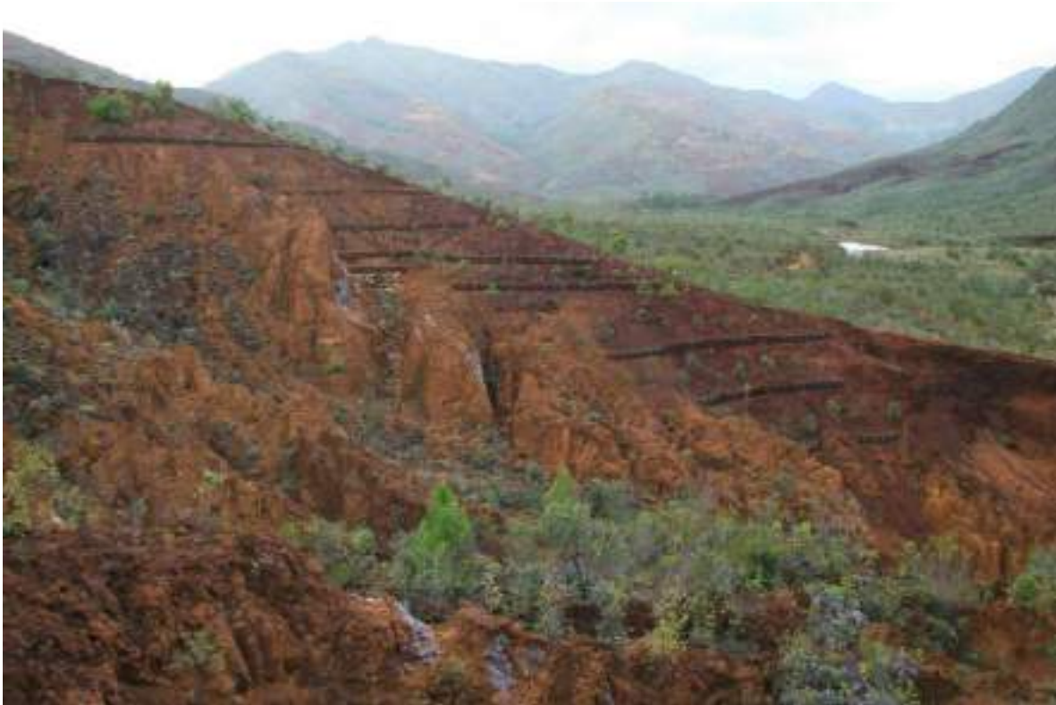
Banquettes grillagées (photo : F. Rey)
