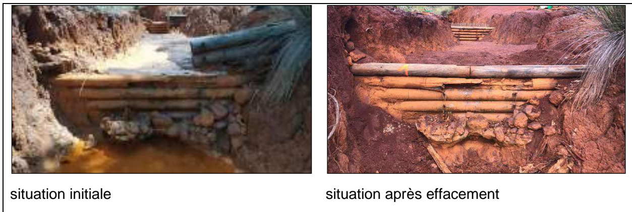
Figure 54 : Procédé n°2 d'effacement du déversoir (seuil 1)
